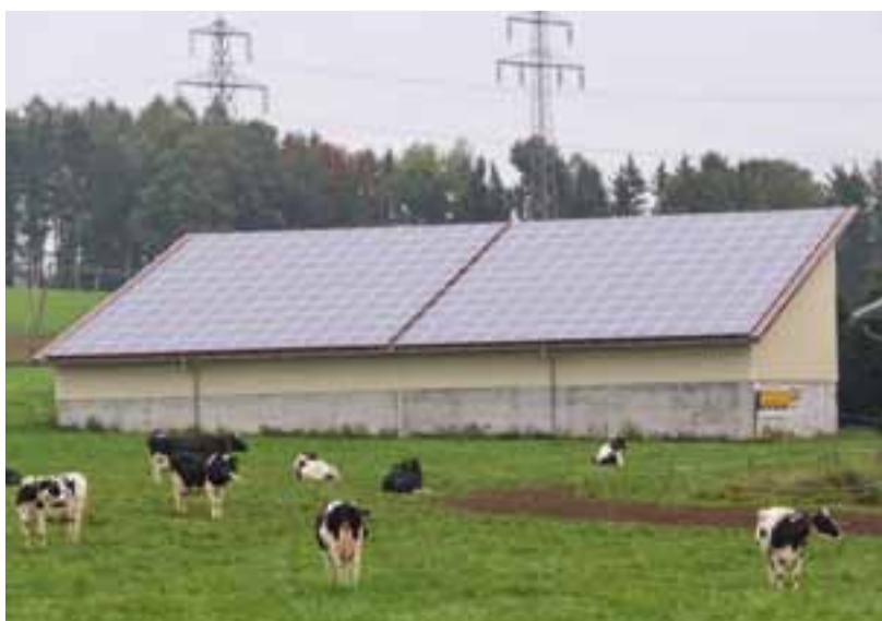
Kapschuur met zonnepanelen.
