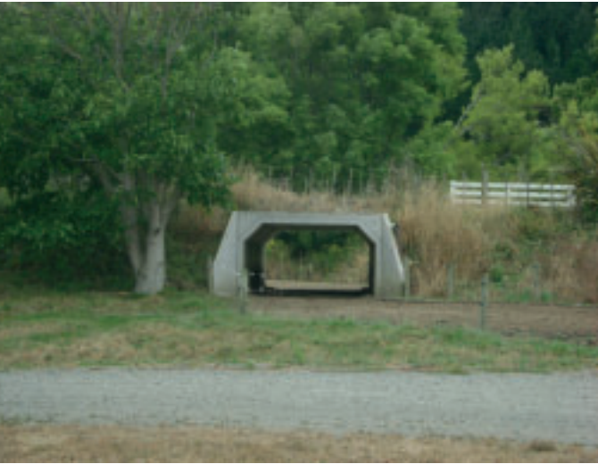
Un boviduc (coût 15.000 à 25.000 euros) permet d'accroître l'accessibilité et de traverser une route en toute sécurité.
