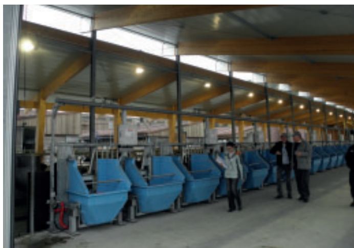
Les auges individuelles avec pesée; en haut, on aperçoit l'espace entre les 2 pentes du toit qui permet une ventilation optimale
