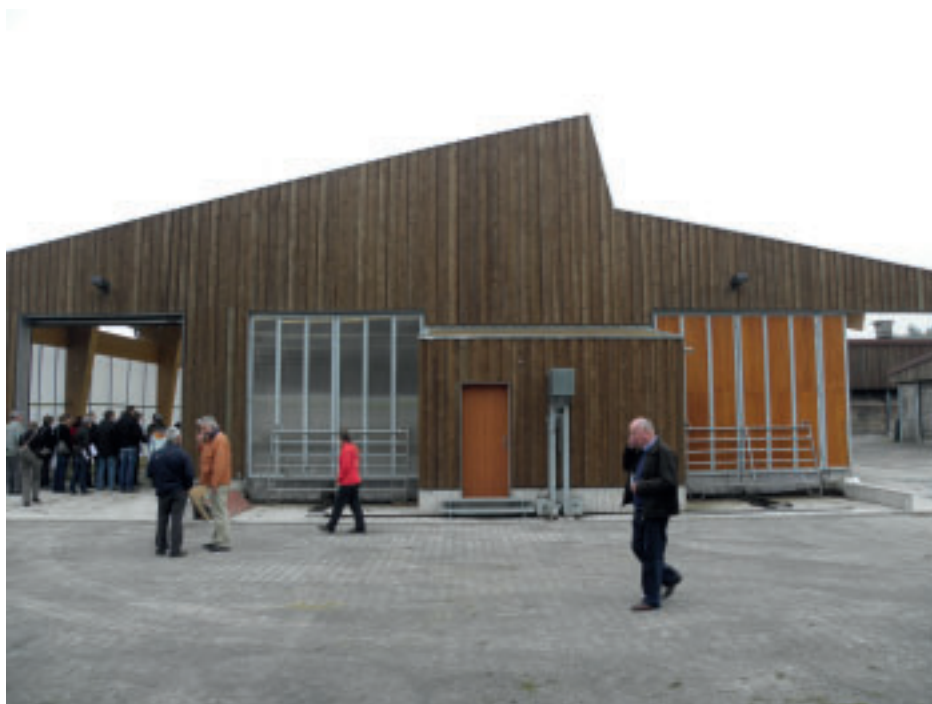
Le toit de la nouvelle étable est à pentes asymétriques afin de permettre une bonne ventilation du bâtiment été comme hiver
